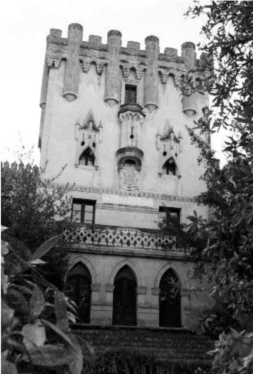
Los Villegas de Cobreces, procedentes de la Casa de Villegas de Villasevil de Toranzo, edificaron su casa solar con unaimponente torre que fue reedificada a finales del siglo XIX en un estilo neogótico, para asemejarla a la torre del Alcázar de Segovia
